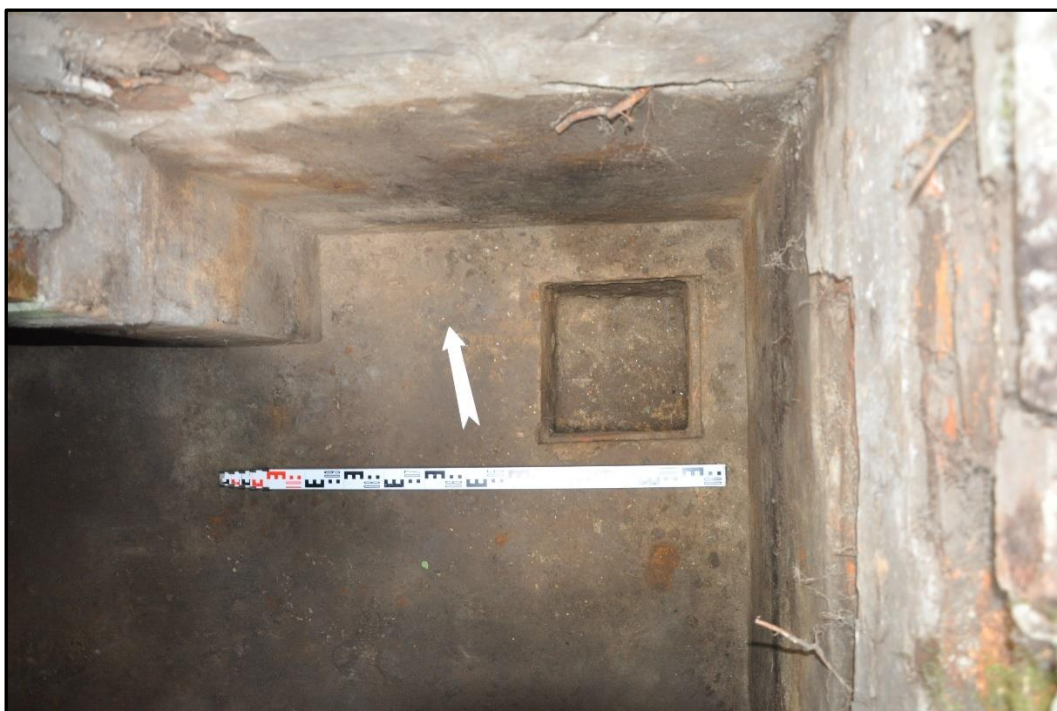
Il. 11. Widok dna zbiornika na nieczystości. Zwraca uwagę zagłębienie umożliwiające umieszczenie wiadra lub ssaka pompy (fot. P. Zawadzki).
