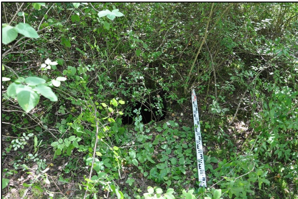
Il. 15. Obszar sondażu N19 przed rozpoczęciem prac. Zwraca uwagę widoczny otwór rewizyjny (fot. P. Zawadzki).
