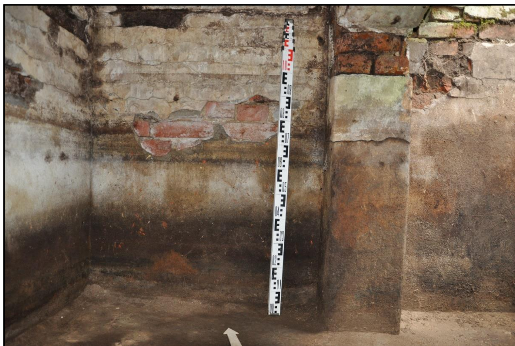
II. 13. Widok wnętrza zbiornika na nieczystości od strony S. Zwraca uwagę filar podtrzymujący łęk fundamentowy ściany działowej przedsionka (fot. P. Zawadzki).
