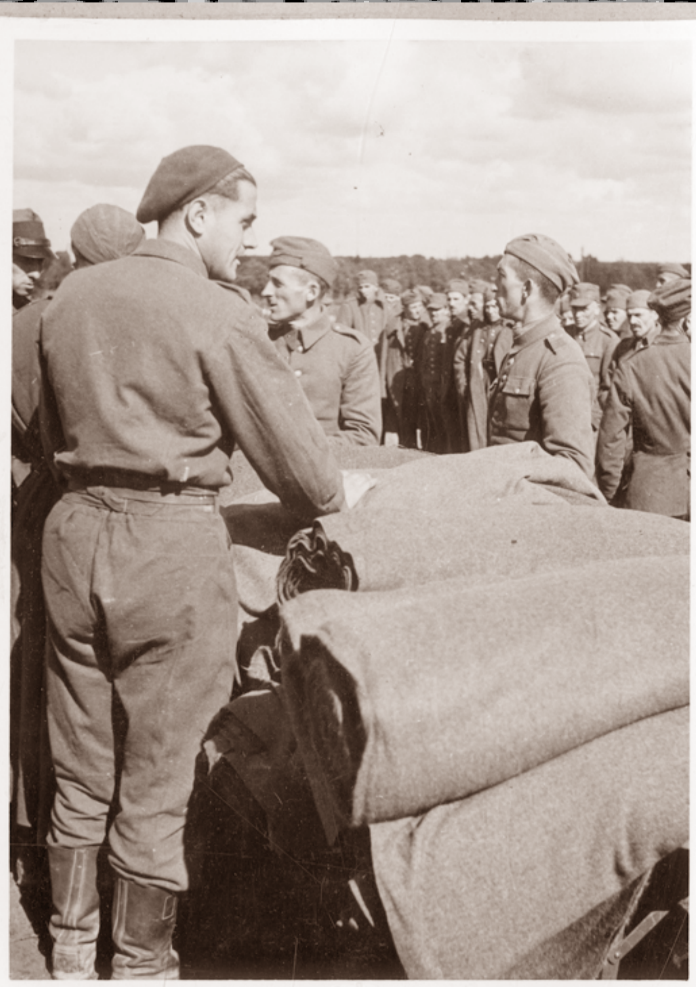
Deckenverteilung im Durchgangslager Görlitz, Leopoldshainerstr.
