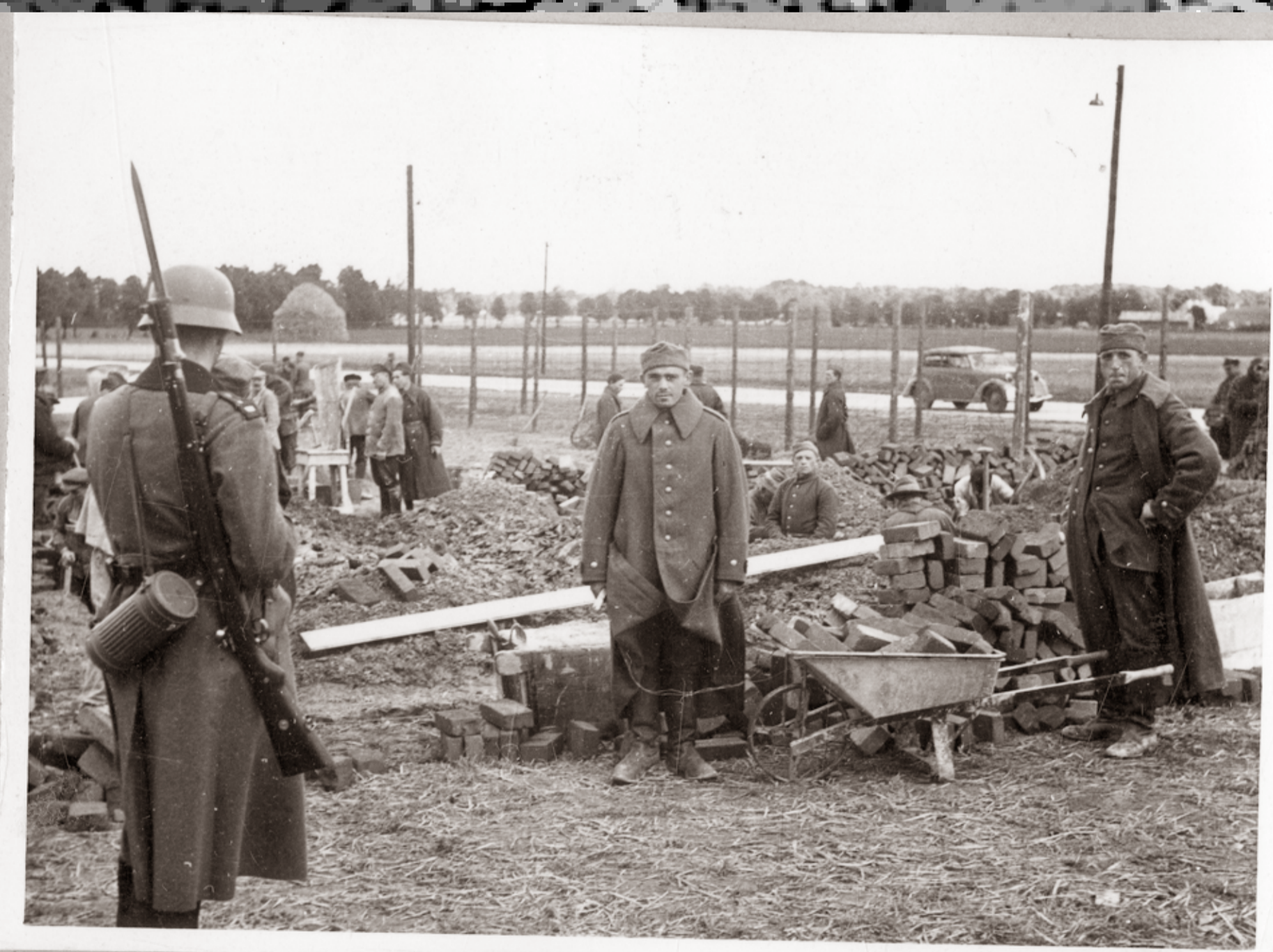
Das Durchgangslager Görlitz, Leopoldshainer- strasse wird gebaut
